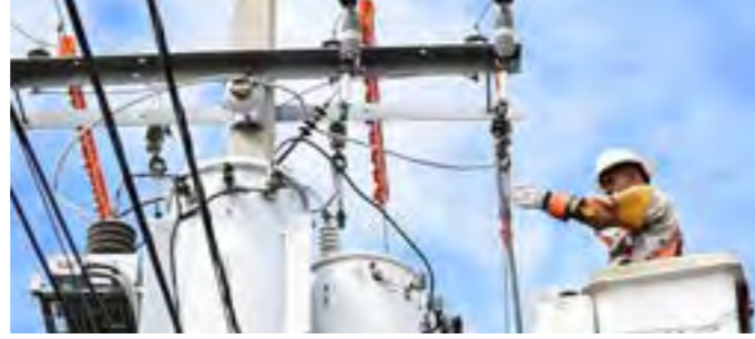
ELEKTRİFİKASYON İŞLERİ / ELECTRIFICATION WORKS
